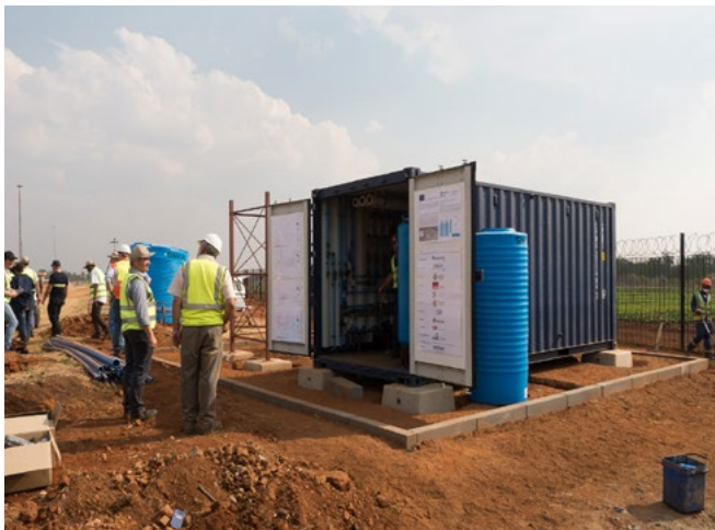
Beim Aufbau der Wasserreinigungsanlage. © Fraunhofer IST
