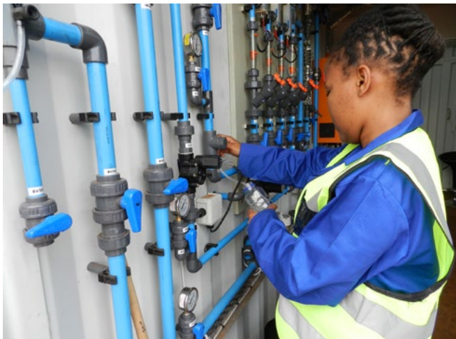
Entnahme einer Wasserprobe im Demonstrator. © Fraunhofer IST
